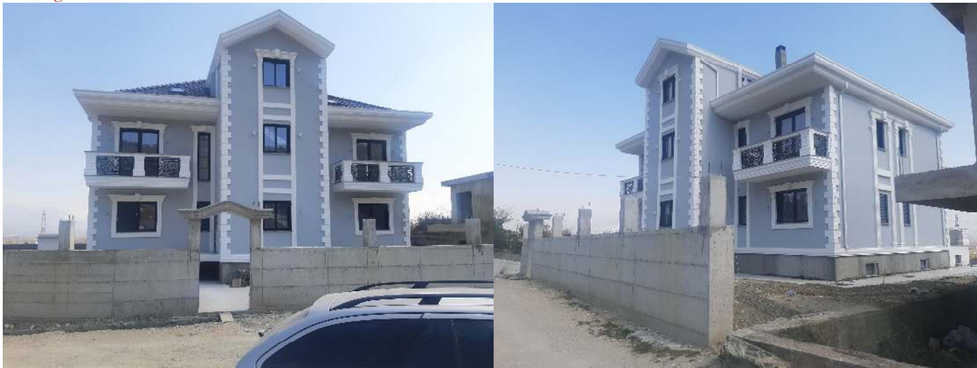
Fig 7. Pamje e Përgjithshme e Pronës,Rrethimit me Mur Betoni dhe Godinës së Banimit nga Peëndimi.
